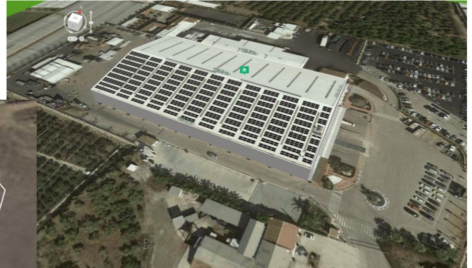
Instalación 407 kWp. Cubierta coplanar
